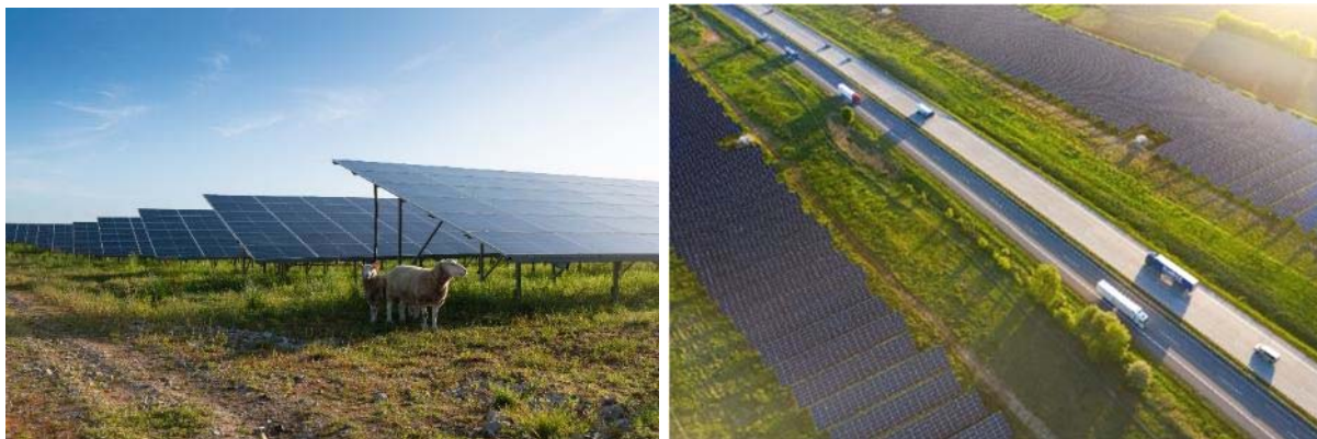
Abbildung 3: Beispiele für Module einer Freiflächen-PVA desselben Vorhabenträgers in Schönbek (Amt Bordesholm) (Quelle: Enerparc AG, Hamburg)
