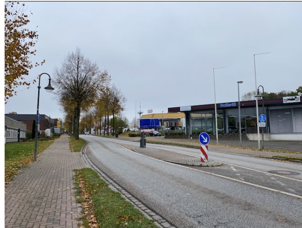
Itzehoer Straße, Blickrichtung Nordosten, Querungshilfe Höhe Hohenwestedter Werkstatt, komb. Fuß-/Radwege
