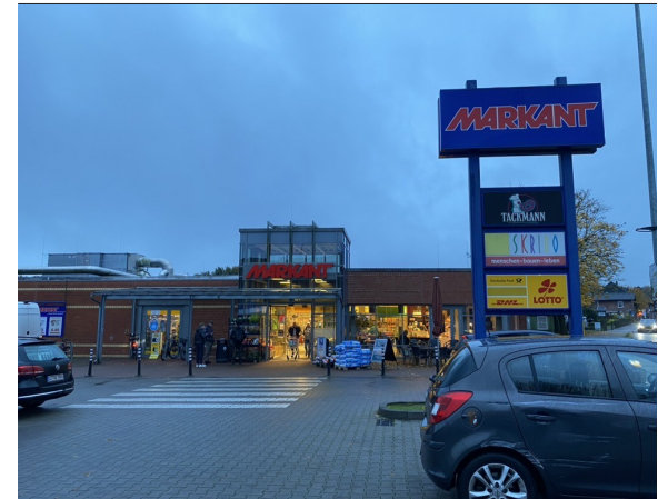
Aukrug ZVB Ortszentrum, Hauptstraße: Moderner Markant Vollsortimenter
