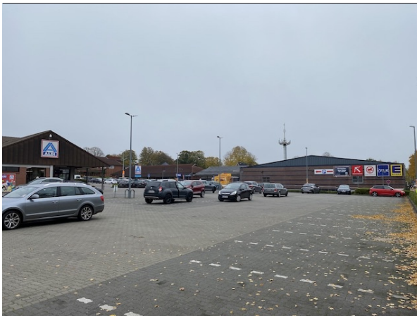
ZVB-Mitte, Am Markt, Blickrichtung Südosten, links: Aldi, rechts: Nahversorgung Edeka/Rossmann, Jysk
